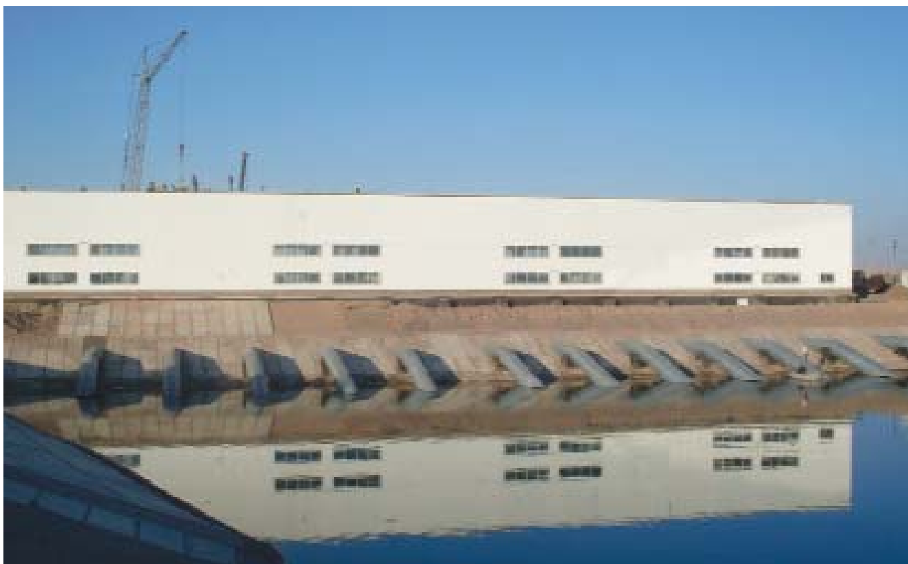
Фото 1. Насосная станция машинного канала Йылгынагыз
