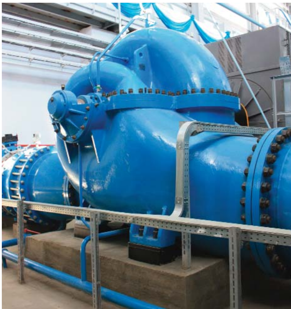
Фото 2. Насосный агрегат типа Д 12500-10 М2
